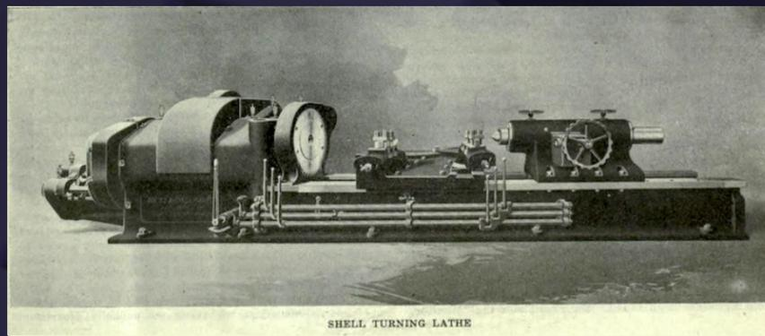
SHELL TURNING LATHE
